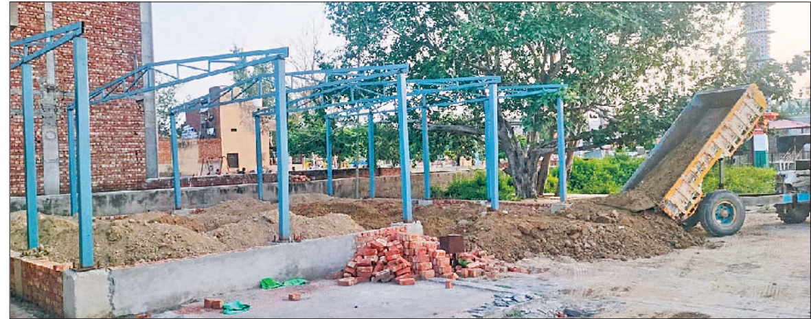
बवानीखेड़ा। बाबा कमाल झील पर निर्माणाधीन योग के लिए शेड।
